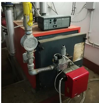
Figura 4.10 - Particolare del bruciatore Riello Gulliver BS4D
